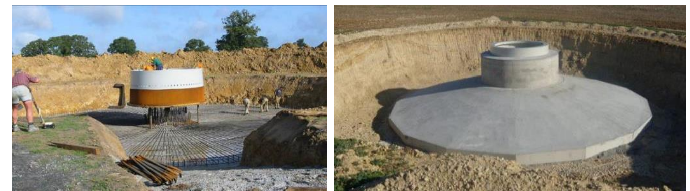
Photo 4 : le ferrailage et le coulage d'une fondation d'éolienne
