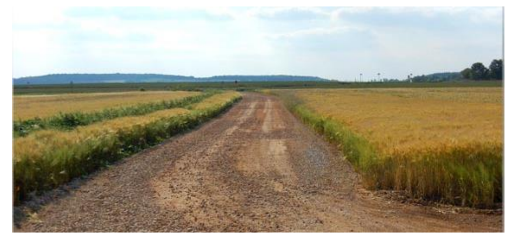
Photo 5 : un exemple de voie d'accès à un parc éolien
